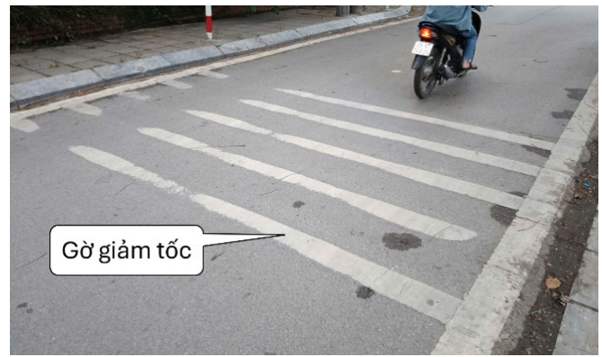
b) Gờ giảm tốc sơn trắng bị mòn đứt quãng
