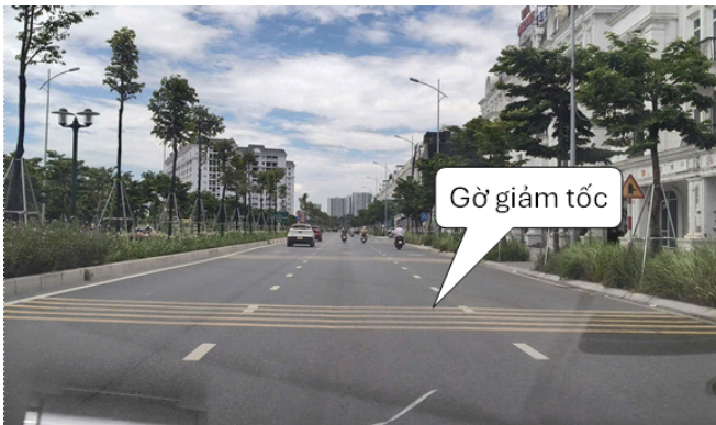
e) Gờ giảm tốc đường nhiều làn xe
