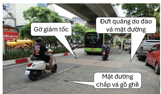
d) Gờ giảm tốc bị mặt đường chấp vá gây đứt quãng
