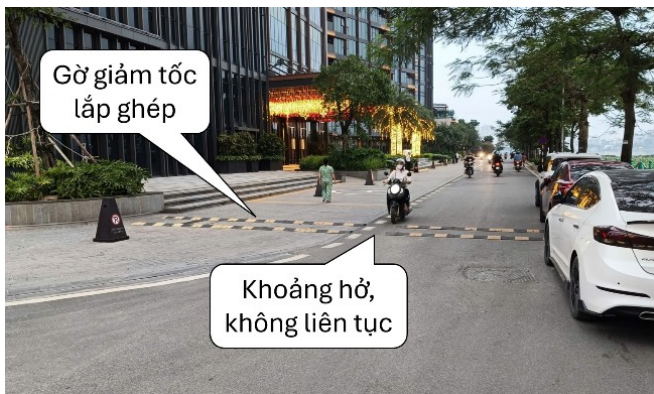
c) Gờ giảm tốc lắp ghép có khoảng hở
